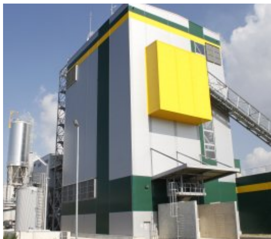
La chaufferie biomasse DRT, photo Cofely
