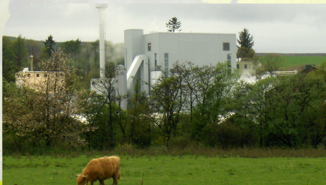
Centrales de cogénération à la biomasse Roths CoRDe, Scotland
