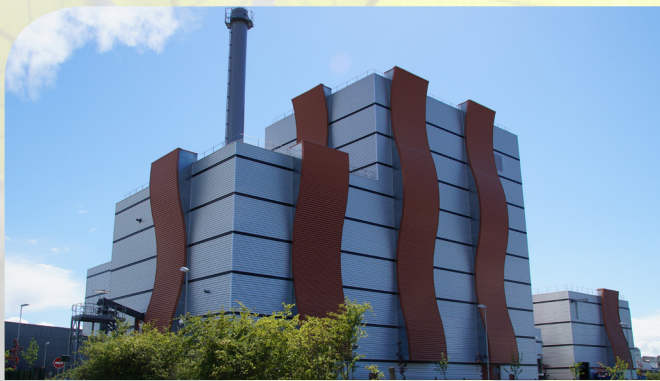
Chaudières à la biomasse SODC, Cofely Services, Orléans, France
