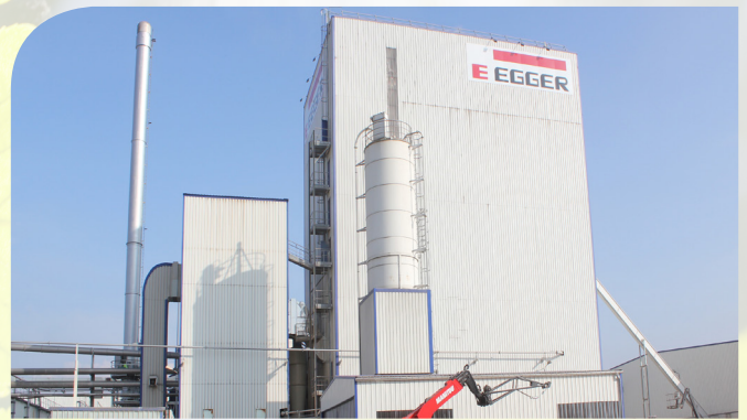
Retrofit / mise à jour Egger, Pannovosges, France
