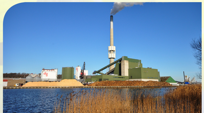
Conversion de combustibles Verdo, Randers, Danemark
