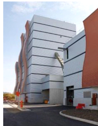
Kraftvarmeværket i Orléans. (2.11.2014).
