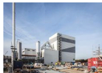
Opførelse af Tilbury Green Power.
